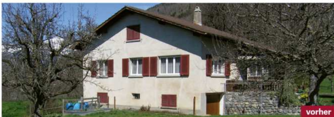
Aussenwärmedämmung mit Mineralwolle
